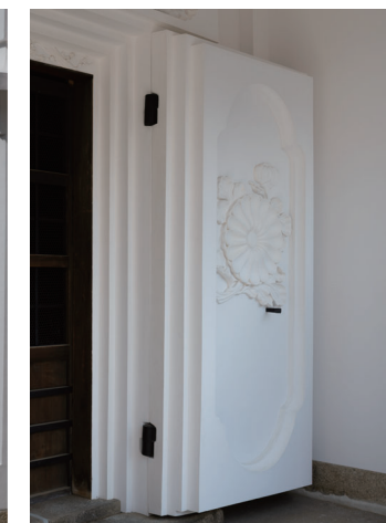
修繕工事後の様子
