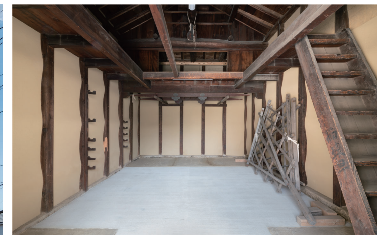
修繕工事後の内部の様子
